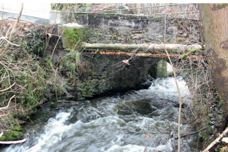
Die Sanierung der Seigbichler Brücke beginnt nach den Osterfeiertagen
